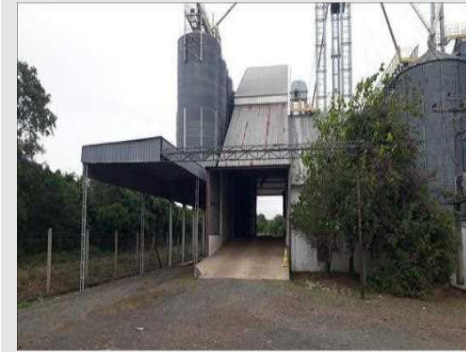
Vista parcial Setor de Carregamento Ferroviário e Moega com Tombador
