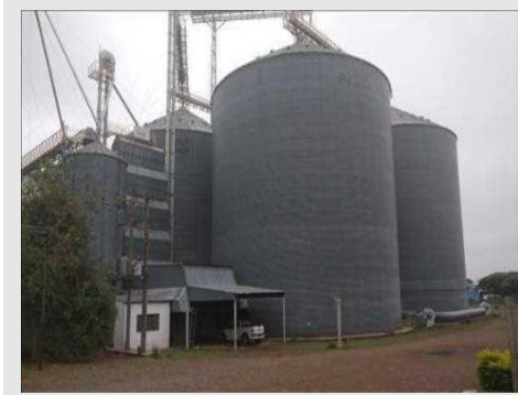
Vista parcial Silos Armazenagem de Grãos
