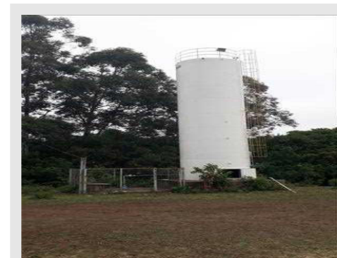
Vista parcial Reservatório Metálico e local do Poço Artesiano
