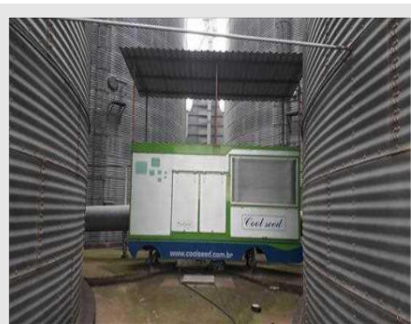
Vista parcial de Área interna entre os Silos Armazenagem de Grãos
