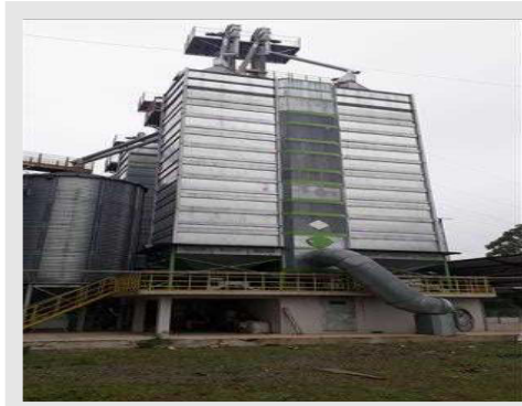
Vista parcial de Estrutura para Secadores Contínuos
