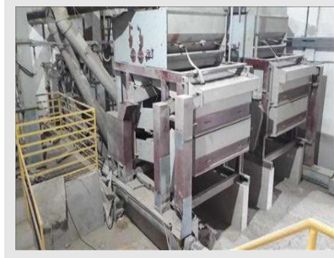
Vista parcial interna Galpão Pré Limpeza
