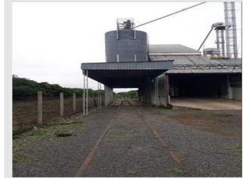
Vista parcial Cobertura para Carregamento Ferroviário com Plataforma Balança Ferroviária
