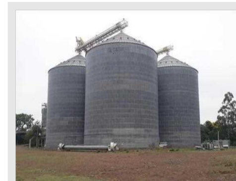
Vista parcial Silos Armazenagem de Grãos
