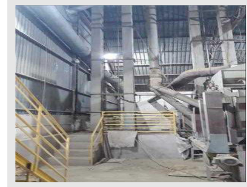
Vista parcial interna Galpão Pré Limpeza
