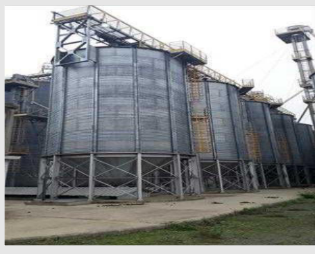
Vista parcial Silos Entre Pré Limpeza e Secador CASP
