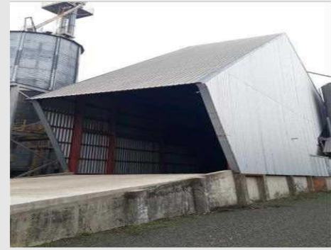
Vista parcial Estrutura e Galpão para Moega e Tombador
