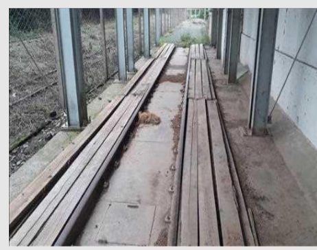
Detalhe Plataforma Balança Ferroviária
