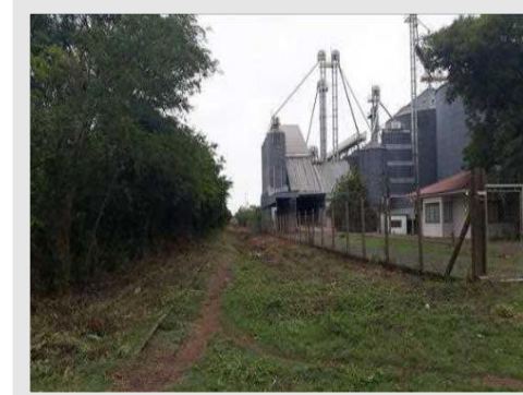
Vista parcial de Antiga Linha Férrea, atualmente desativada, vizinha ao Imóvel Avaliando
