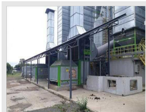
Vista parcial Cobertura para Fornalhas Secadores Contínuos
