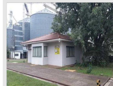
Vista parcial Prédio Administrativo
