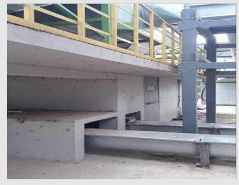
Vista parcial de Estrutura para Secadores Contínuos
