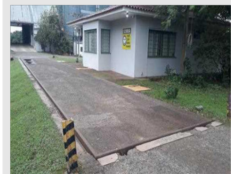
Vista parcial Plataforma Balança Rodoviária
