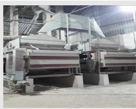
Vista parcial interna Galpão Pré Limpeza
