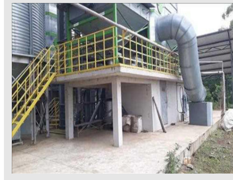
Vista parcial de Estrutura para Secadores Contínuos
