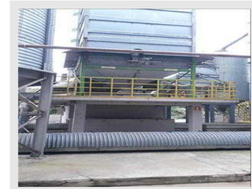
Vista parcial de Estrutura para Secadores Contínuos
