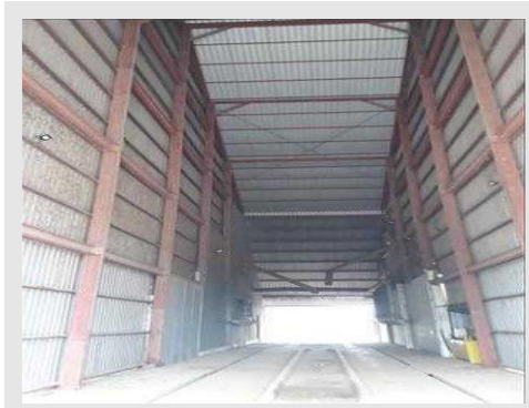
Vista parcial interna do Galpão para Moega com Tombador Hidráulico
