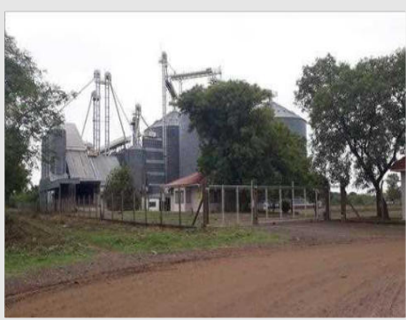
Vista do Imóvel Avaliando
