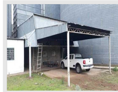
Vista parcial Cobertura para Garagem e Fornalha Secador CASP
