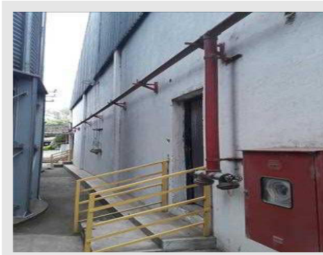
Vista parcial da Lateral do Galpão Pré Limpeza
