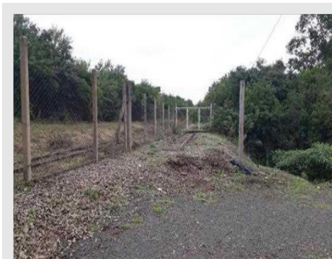
Detalhe de Portão com Linha Férrea (desativada)
