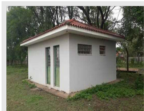
Vista parcial Prédio para Vestiários
