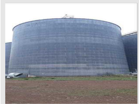
Detalhe de um dos Silos para Armazenagem de Grãos
