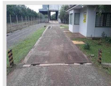
Vista parcial Plataforma Balança Rodoviária
