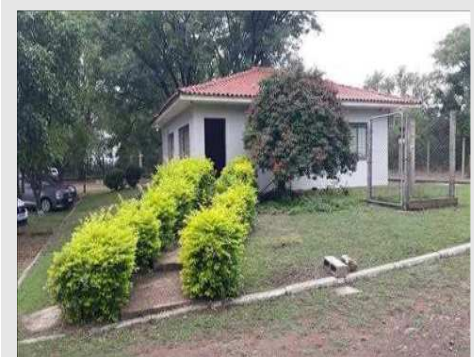
Vista parcial acesso ao Prédio Administrativo
