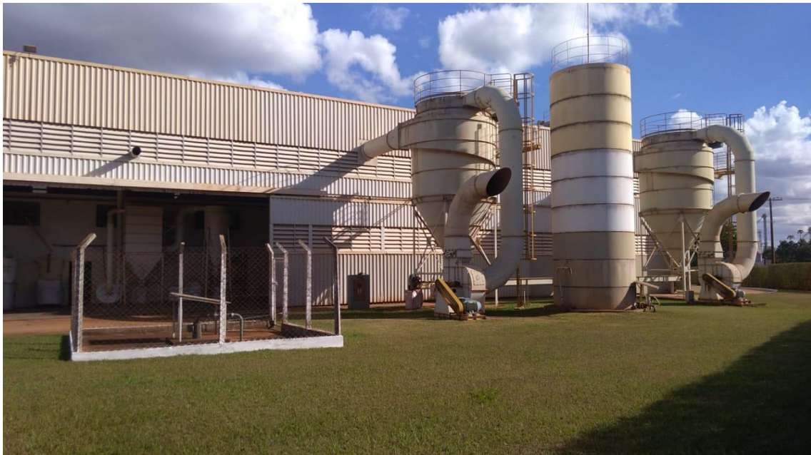
- SISTEMA DE DESPOLUIÇÃO E TRANSPORTE -
