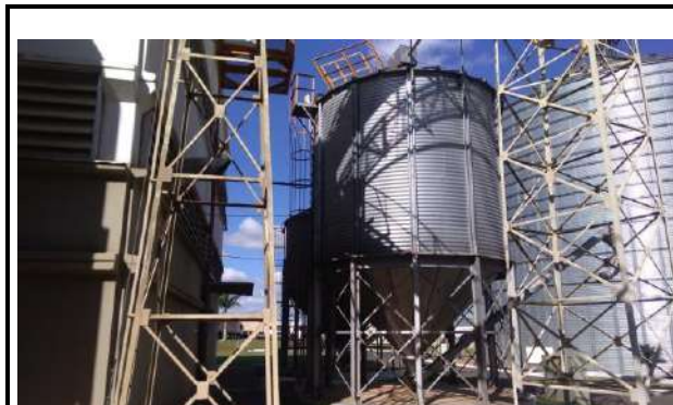
- SILO DE ARMEZAMENTO -
