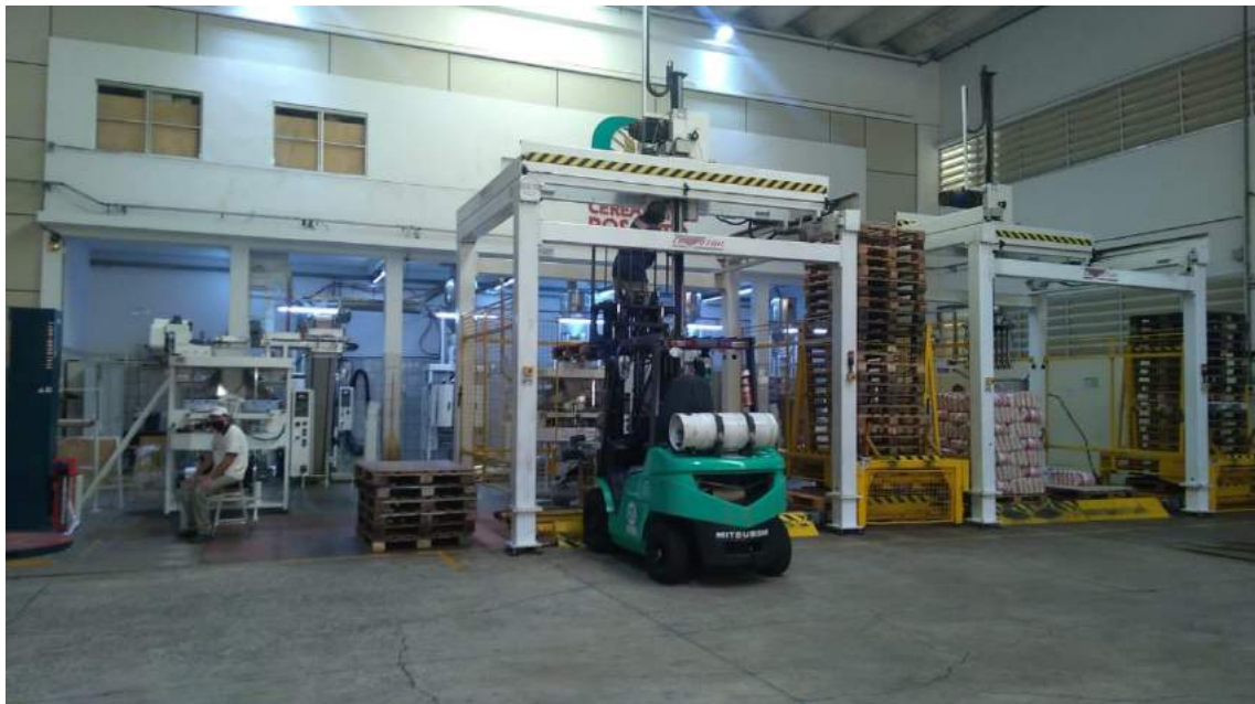
- SISTEMA DE EMPACOTAMENTO -
