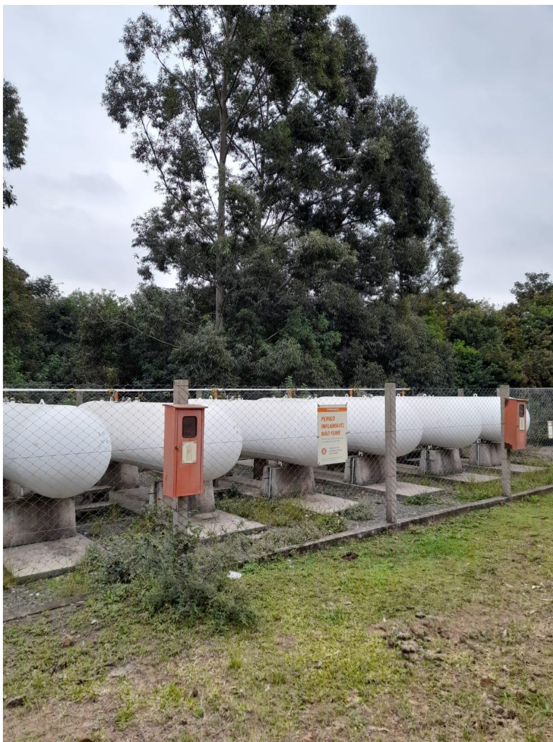
- CENTRAL DE GÁS -
