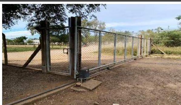
- PORTÃO DE ENTRADA -
