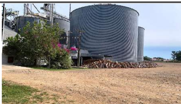
- SILOS DE ARMAZENAMENTO -
