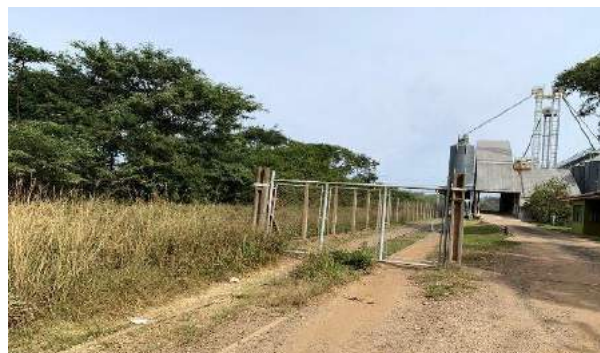
- PORTÃO DE ENTRADA -
