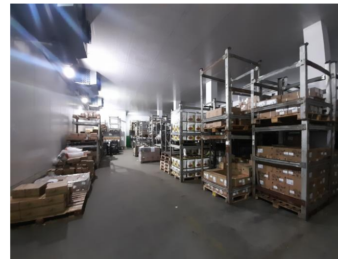
Câmara de Refrigeração
