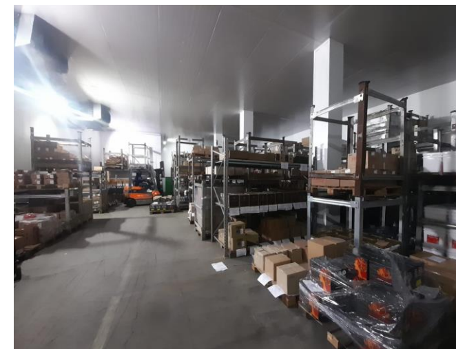
Câmara de Refrigeração
