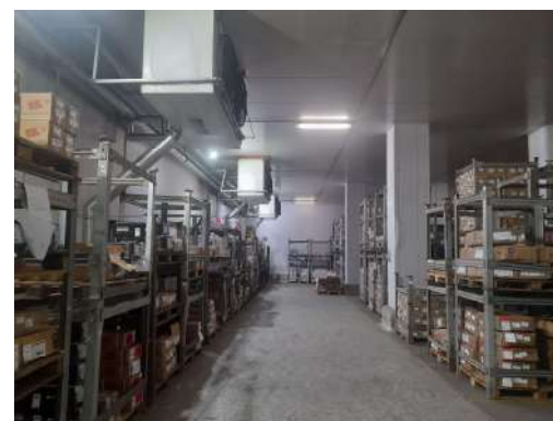
Câmara de Refrigeração
