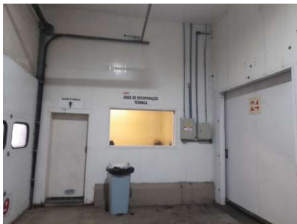
Área de Recuperação Térmica
