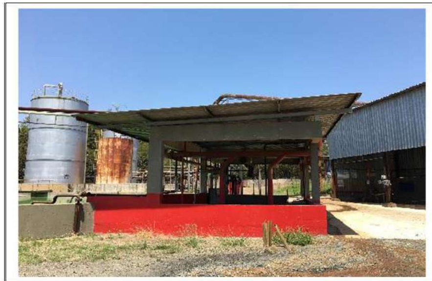
FOTO N. 2 CASA DE BOMBAS MARACANÃ
