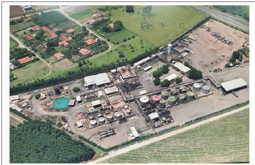
FOTO N. 1 VISTA AÉREA DA UNIDADE
