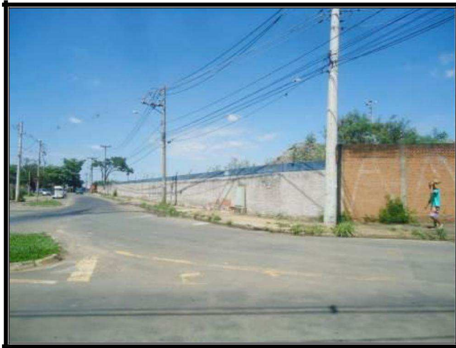
Vista da frente do imóvel avaliando para a Travessa Alcides Menegatti.
