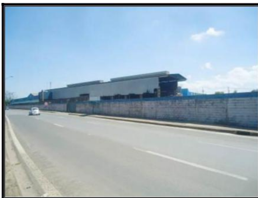
Vista da frente do imóvel avaliando para a Rodovia Cornélio Pires.
