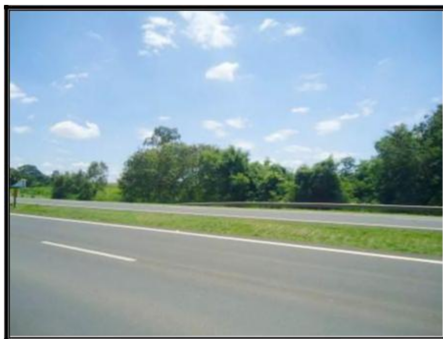
Vista da frente do imóvel avaliando.
