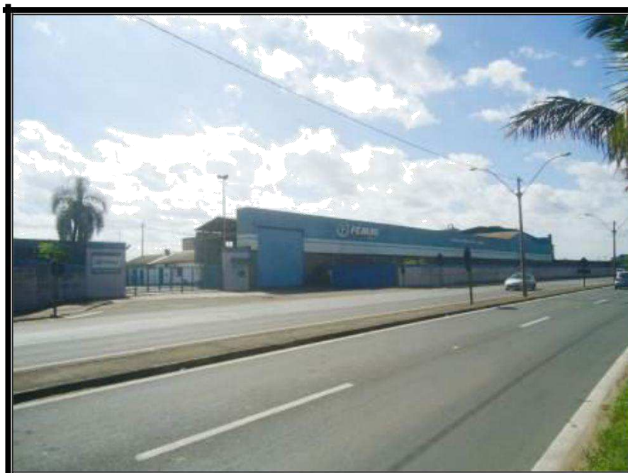
Vista da frente do imóvel avaliando para a Rodovia Cornélio Pires.
