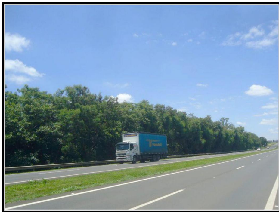
Vista da Rodovia Cornélio Pires que dá acesso ao imóvel avaliando.
