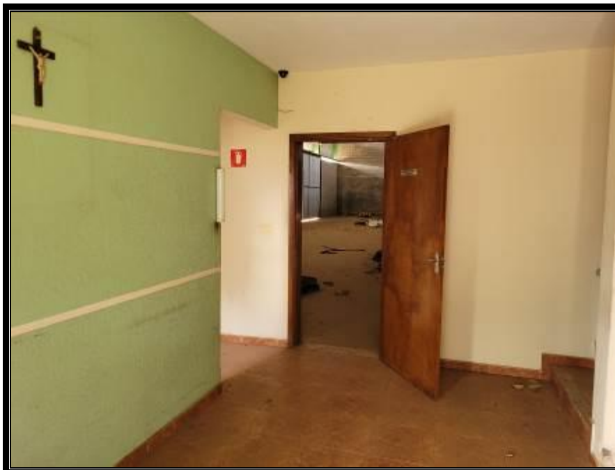
Recepção – pavimento térreo.
