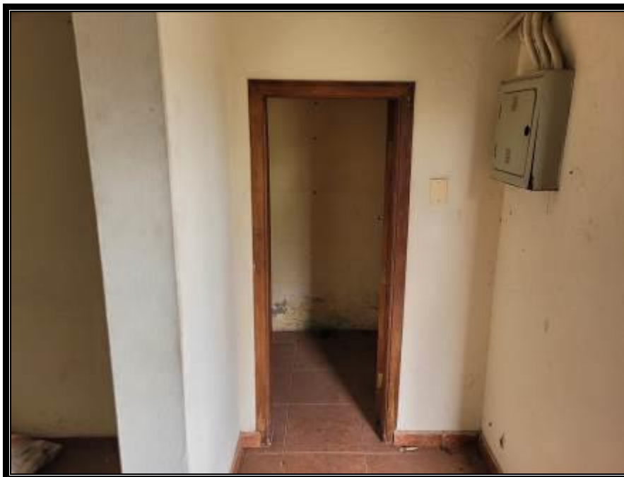
Despensa – pavimento térreo.
