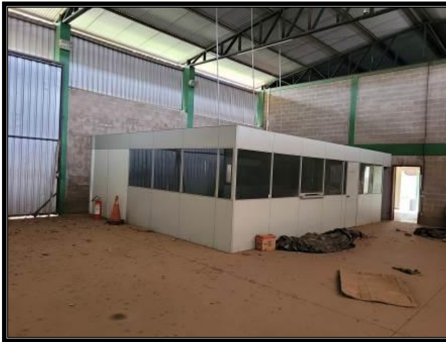
Escritório – pavimento térreo.
