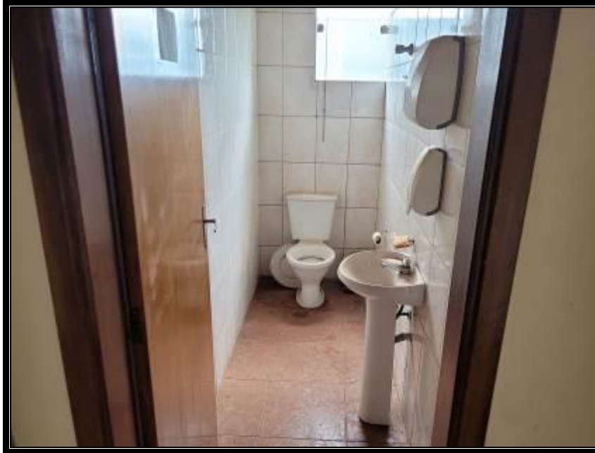
Sanitários – pavimento superior.
