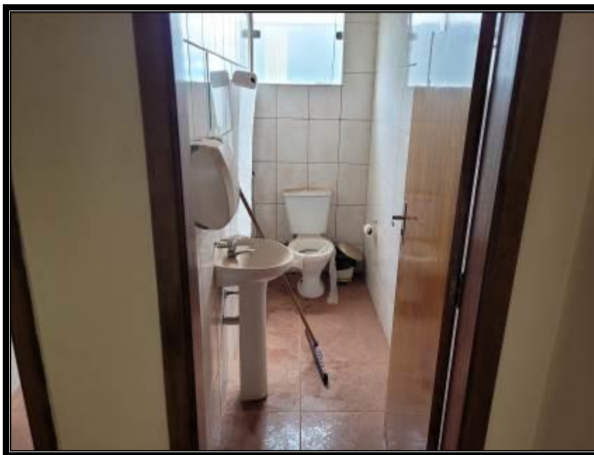
Sanitários – pavimento superior.
