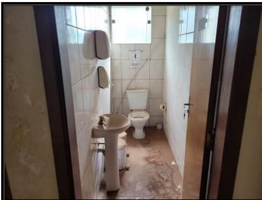
Sanitários – pavimento térreo.
