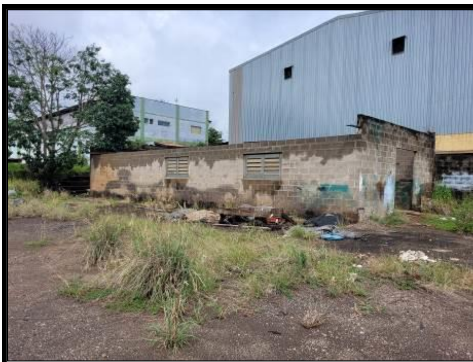
Vista interna do lote 09, destacando-se a edificação sem valor comercial.
