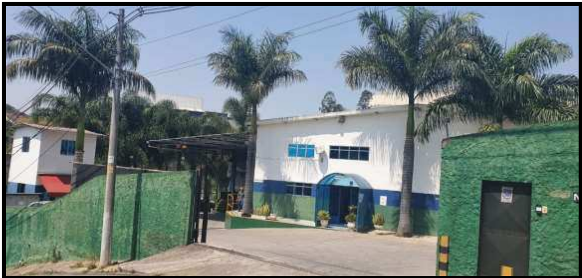
Figura 3 – Frente do imóvel, com o portão automático da empresa aberto.
