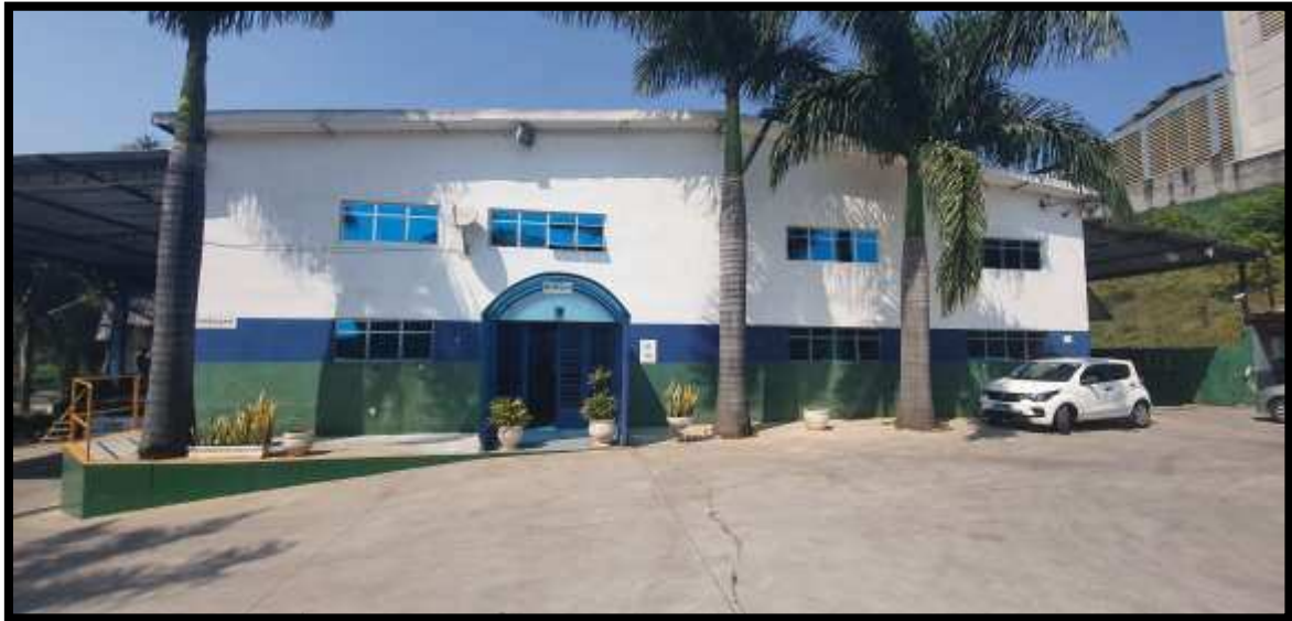
Figura 5 - Fachada principal do galpão.
