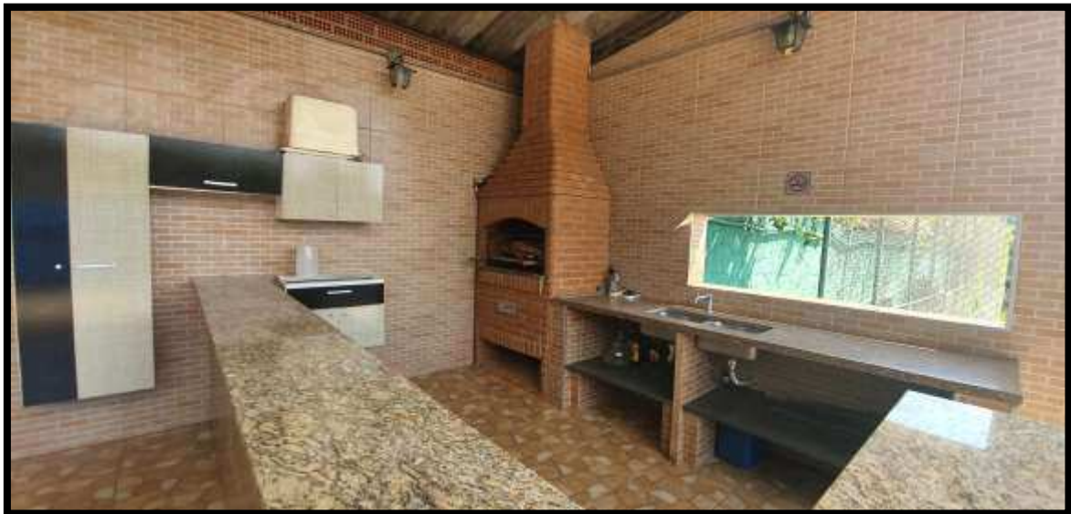
Figura 20 - Churrasqueira de alvenaria com cubas e bancadas de pedra em área coberta.
