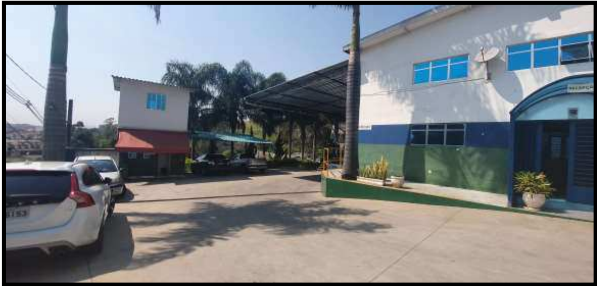
Figura 7 - Guarita com toldo, 2 vagas cobertas e doca inferior.
