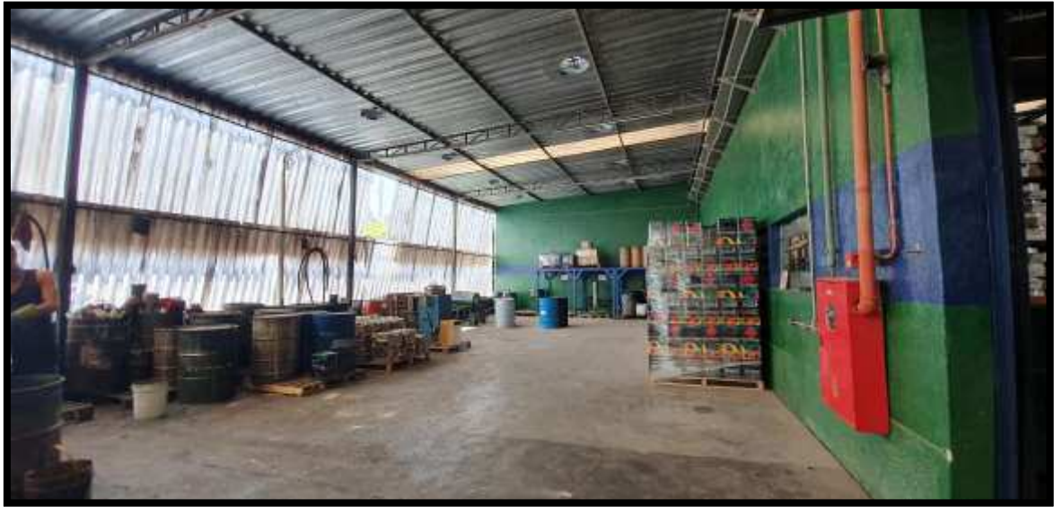
Figura 11 - Lateral esquerda do galpão.
