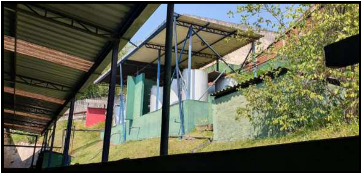
Figura 8 - Tanques para produtos químicos.
