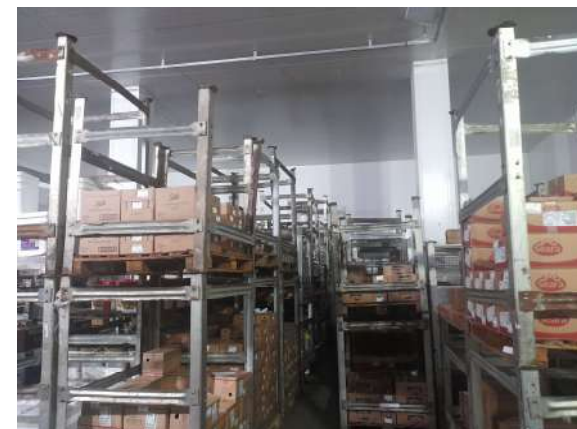
Câmara de Refrigeração
